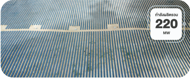
โรงไฟฟ้าพลังงานแสงอาทิตย์ เมืองมินบู ประเทศเมียนมา
