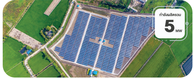
โรงไฟฟ้าบางภาะ จังหวัดนครปฐม ประเทศไทย
